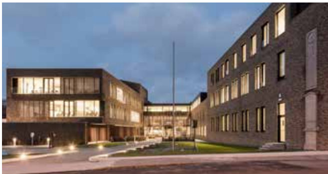
Het nieuwe hoofdkwartier van Bekaert in Zwevegem (foto Sileghem en partners)
